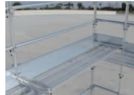
施工イメージ
